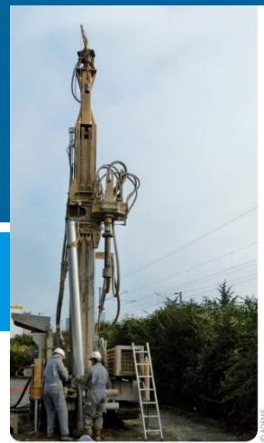
Mise en place d'un puits géothermique pour PAC sur EST
